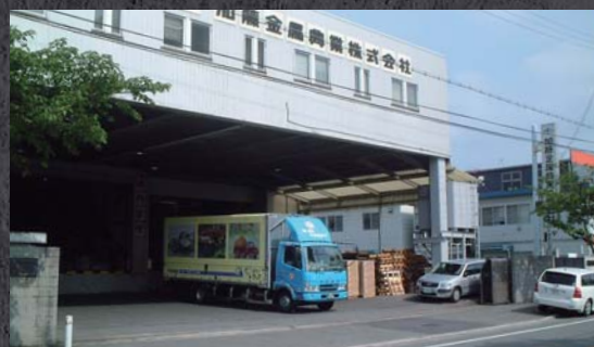
HIGASHIOSAKA LOGISTICS CENTER 東大阪流通センター 21-7, Yoshita shimojima Higashiosaka-city, Osaka, Japan TEL: (81)-72-964-0735 FAX: (81)-72-964-0531
